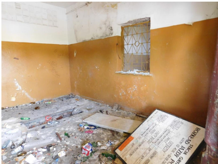
Fot. 1 Wnętrze budynku dworca kolejki wąskotorowej
